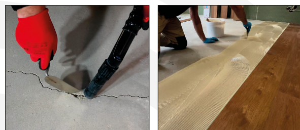
Gruntowanie i wyrównywanie podłoża – podłoże niechłonne WIM GRUNT PRO9 WIM R2
