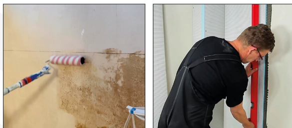
Gruntowanie i wyrównywanie ścian WIM GRUNT EPOKSYDOWY WIM ZAPRAWA SW40 WIM PŁYNNĄ FOLIA (strefy mokre)
