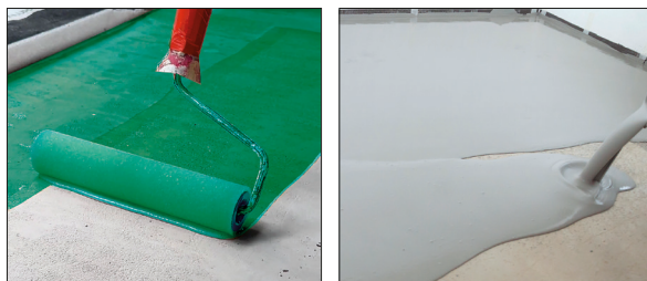
Gruntowanie i wyrównywanie podłoża – podłoże chłonne WIM GRUNT PRO9 WIM WYLEWKA EXTRA WIM WYLEWKA MAX30
