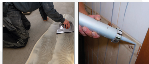
Klejenie płyt WIM R2 (posadzka, ściana – strefy mokre) WIM STRONG (ściana)
