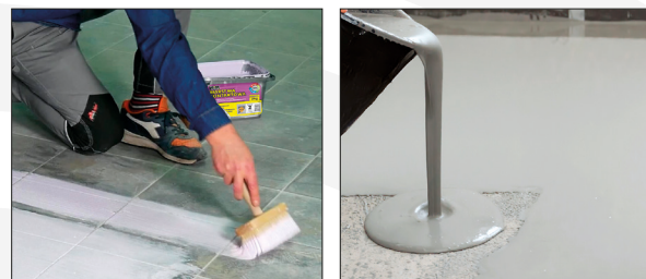
Gruntowanie i wyrównywanie podłoża – podłoże niechłonne WIM WARSTWA KONTAKTOWA WIM WYLEWKA EXTRA WIM WYLEWKA MAX30
