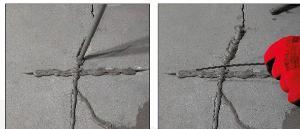
Naprawa pęknięć i uszkodzeń podłoża WIM STRONG TURBO WIM KLAMRY DO ZSZYWANIA BETONU
