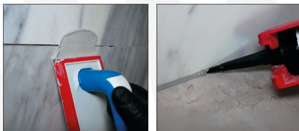
Spoinowanie płyt WIM EPOXYD HQ WIM SILIKON MATT
